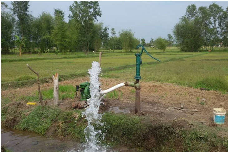
जरुवाबस्तीमा बोरिङ निर्माण
