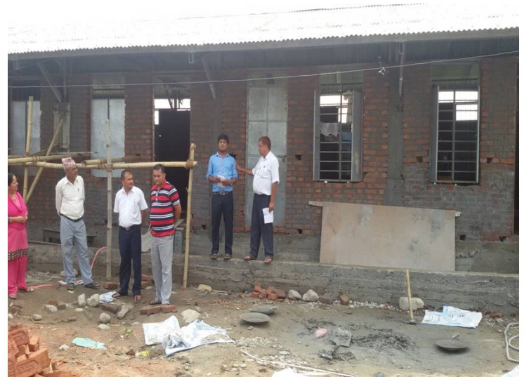
बालकल्याण प्रा वि भवन पुन निर्माण नपा ५
