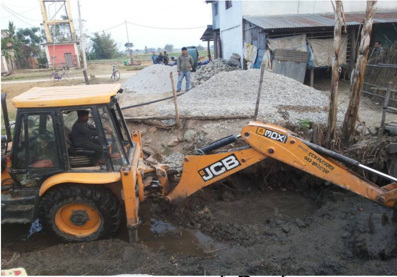
नपा ३ मा कल्भटे निर्माण
